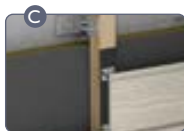
C Klips z wkrętem mocującym
