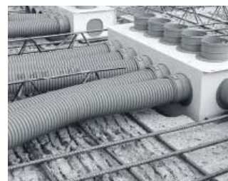
Strop w stanie surowym z przewodami powietrznymi
