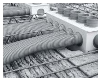
Strop w stanie surowym z przewodami powietrznymi
