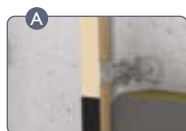
Wspornik regulacyjny 110-150mm lub 150-190mm + termostop PCV 50x60x5mm
